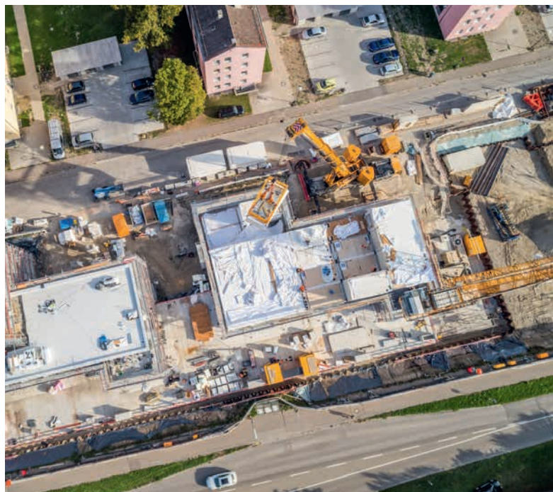
Wohnungsbaustelle in Manching: Gebaut wird mit Modulen Foto: Firmengruppe Max Bögl/Reinhard Mederer
